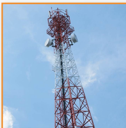
DISEÑO DE ESTRUCTURAS Y MONTAJES INDUSTRIALES
